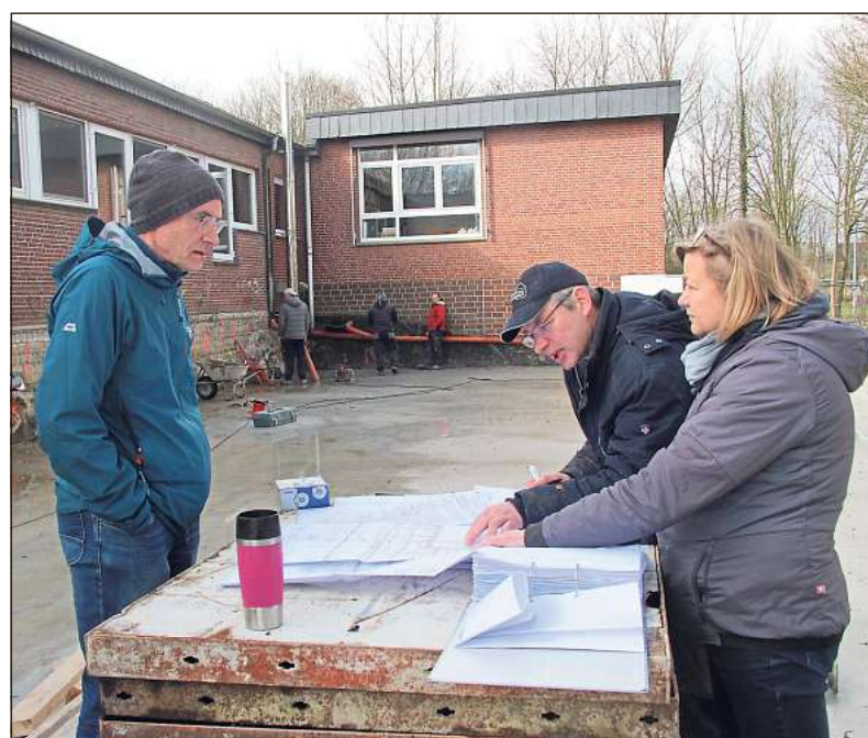
Baustellenbesprechung: (v. l.) Matthias Blume, Ingo Wittkemper und Stefanie Schürmann. Foto: Lange
